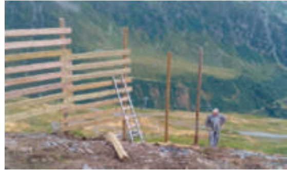
Construction d'une barrière à vent sur la piste Gélinotte
