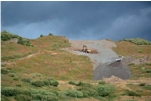
Travaux de terrassement de la piste Roc Noir
